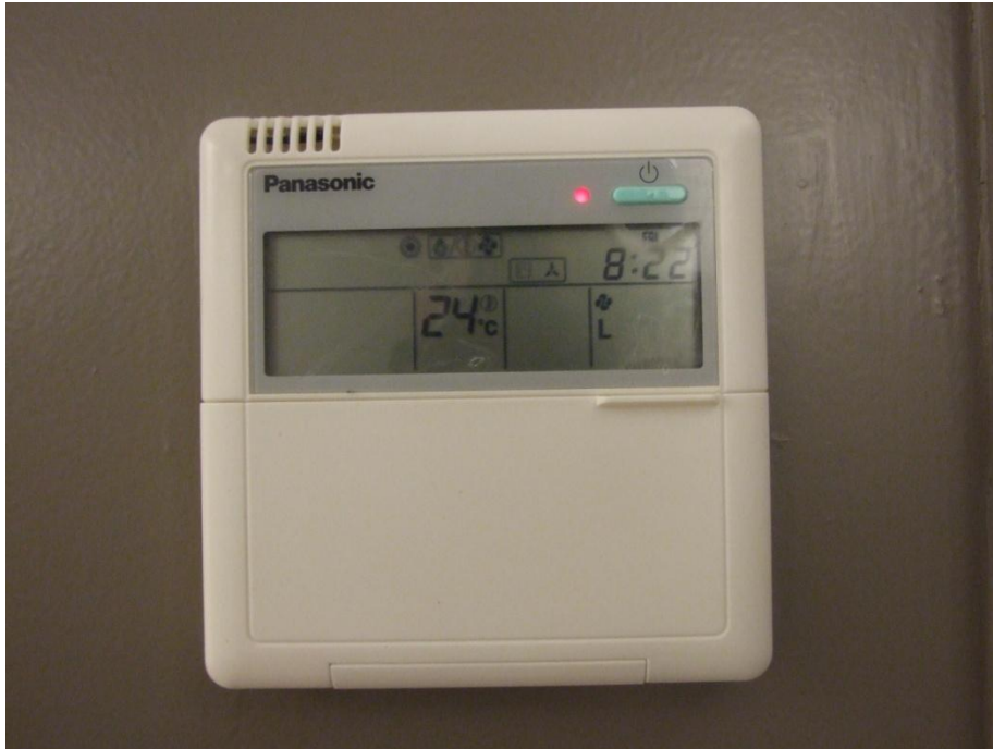
LÁMINA 1: Termostato para control de la temperatura ambiente en la sala de estudio (24º)
